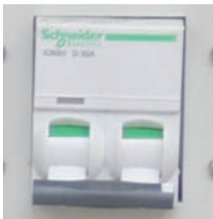
图9. 主电源开关
